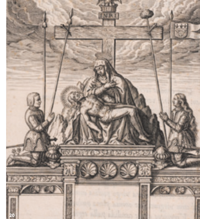
20. Piéta dite Statue du pont d'Orléans , représentation du 2 e état vers 1600 d'après le monument érigé en 1502 sur le pont des Tourelles, estampe par L. Gaultier. © François Lauginie, Centre Jeanne-d'Arc d'Orléans.
